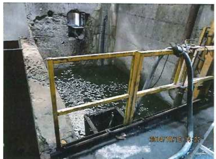
006.jpg Fosse de décantation
