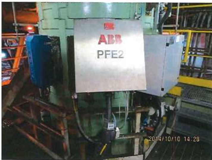
009.jpg Sondes sur une cheminée pour l'analyse des gaz
