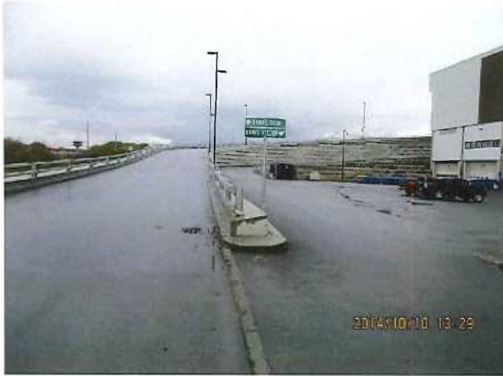
001.jpg Nouvelles rampes d'accès
