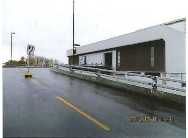
002.jpg Rampe d'accès à la fosse à déchets
