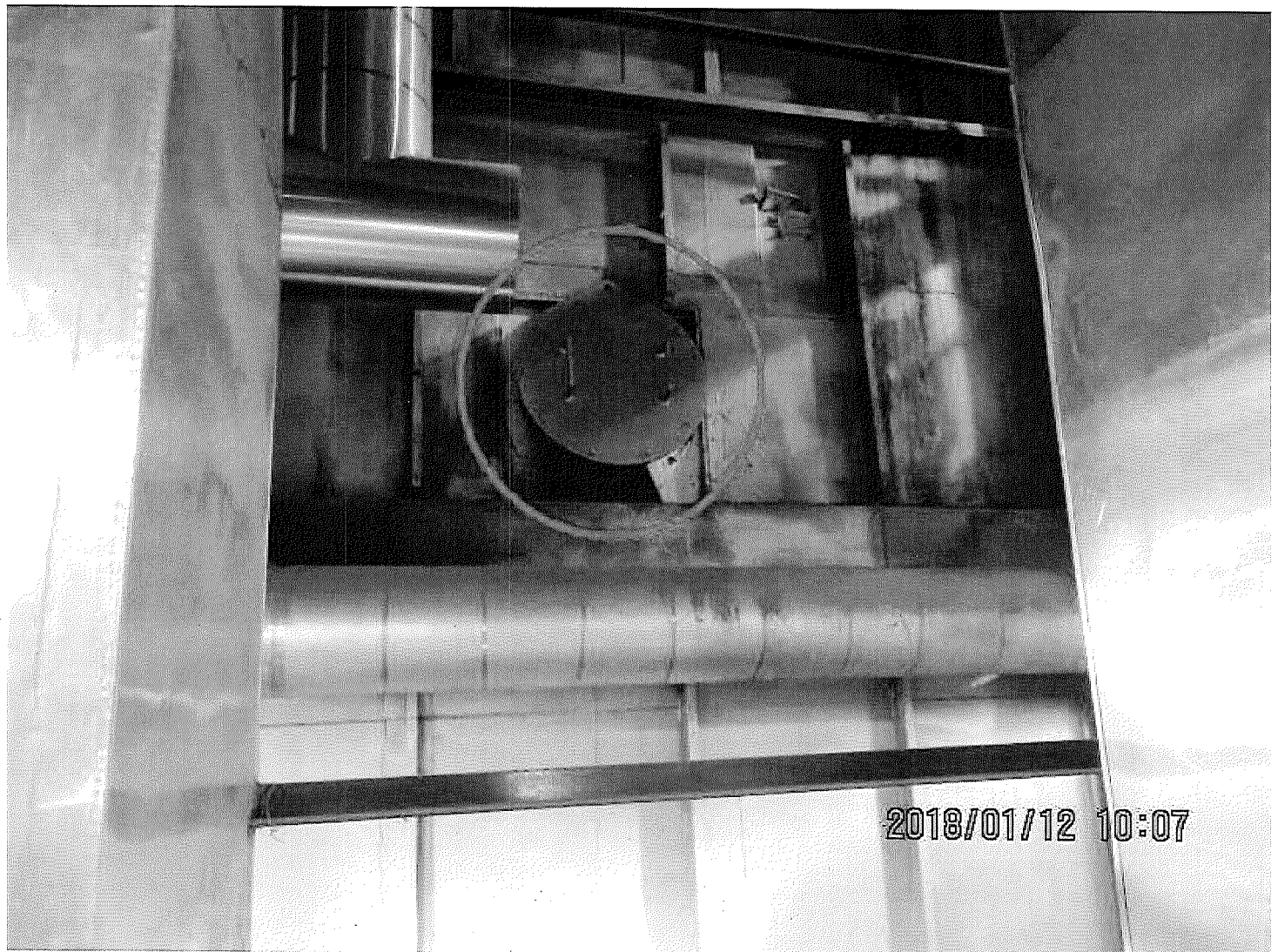
IMG_0004 (800x600).jpg Four no.1 - trou pour l'installation d'un brûleur au sud-ouest de la chambre de combustion
